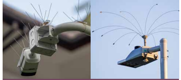
Spitze Spikes bergen ein hohes Verletzungsrisiko für Tauben, besser sind stumpfe Spikes oder eine Variante wie im Bild rechts.
